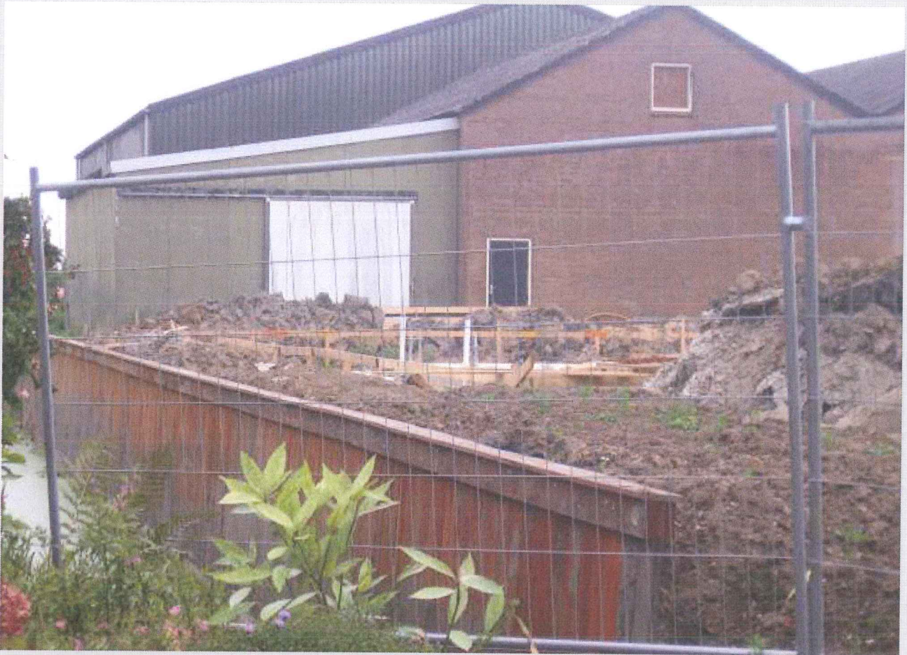
Nog te slopen bedrijfsbebouwing
