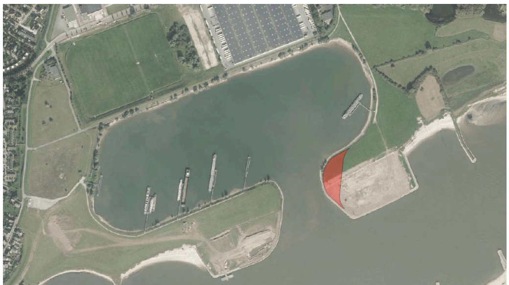
Figuur 4. Luchtfoto overnachtingshaven Haaften. In rood is de beoogde ontgroning aangegeven t.b.v. de invaartverbreding. Het zandkleurige deel dat deels overlapt met het plangebied betreft het verlaagde kribvak.
