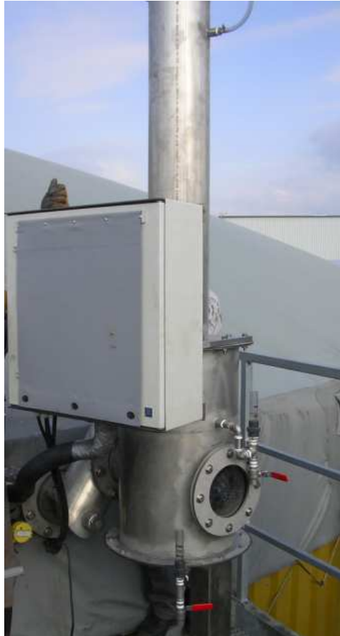
Afbeelding 5: Over- en onderdrukbeveiliging
