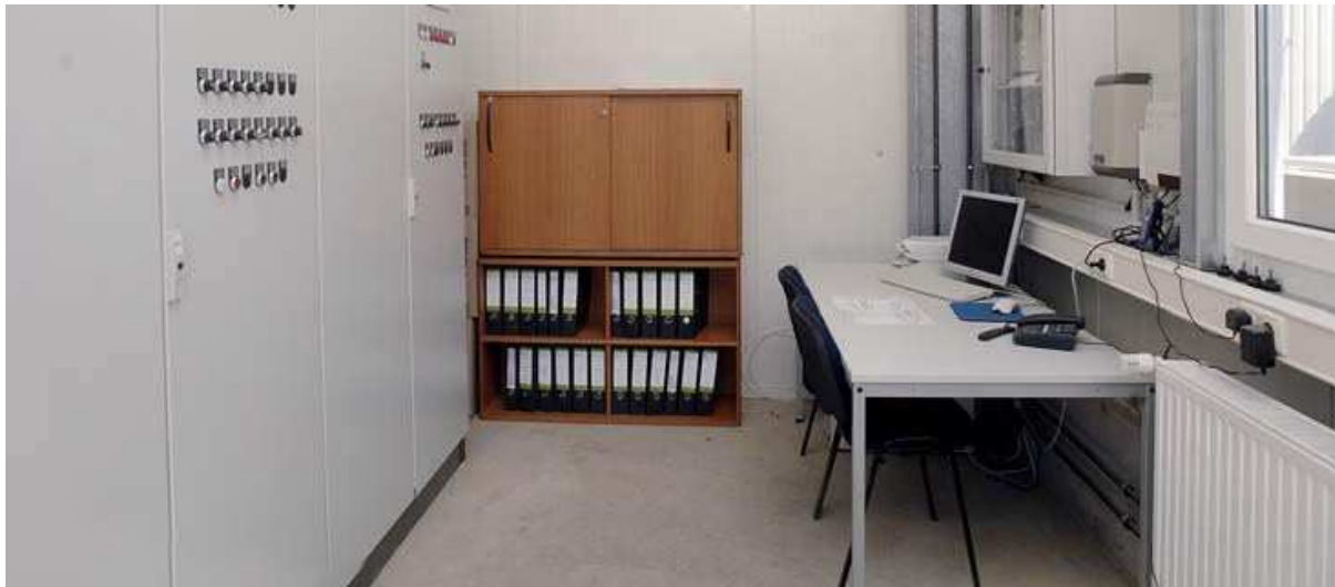
Afbeelding 13: Schakelkastruimte
